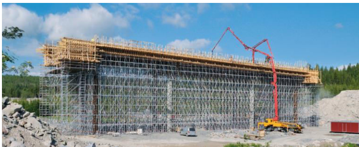
1 pav. Tilto betonavimo darbuose naudojama atraminių pastolių sistema
