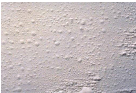
2 pav. Pūslėtas tinkas [6]
