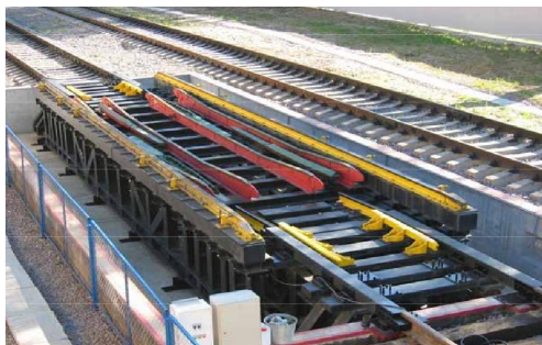
1 pav. Talgo automatinė vėžės keitimo sistema [2]
